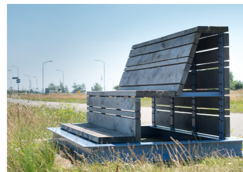
Houten planken vouwen over de staalconstructie.
